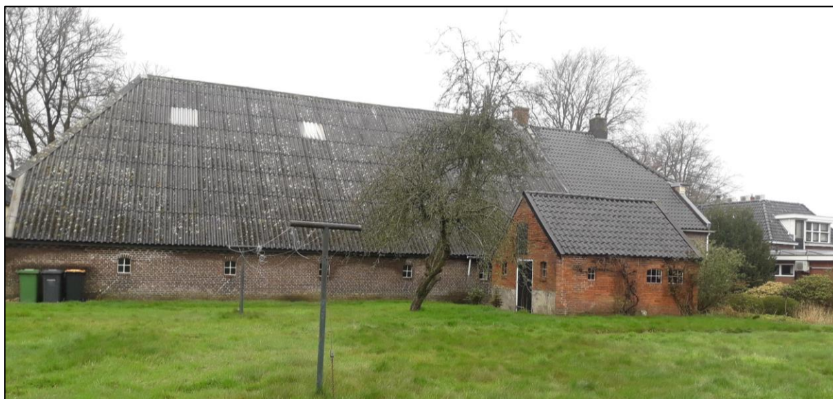
Figuur 2.2 Achterzijde Asserstraat 5 met losstaand schuurtje.
