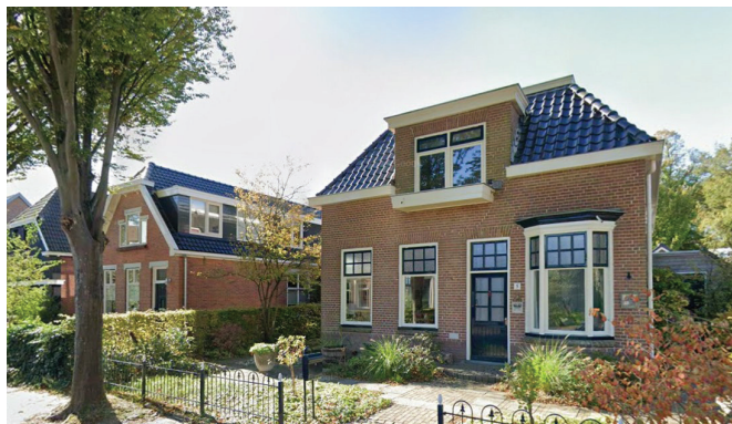
Stationsstraat: roodbruin metselwerk met gevelrisaliet
