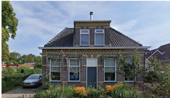
Stationsstraat: roodbruin metselwerk met gevelrisaliet
