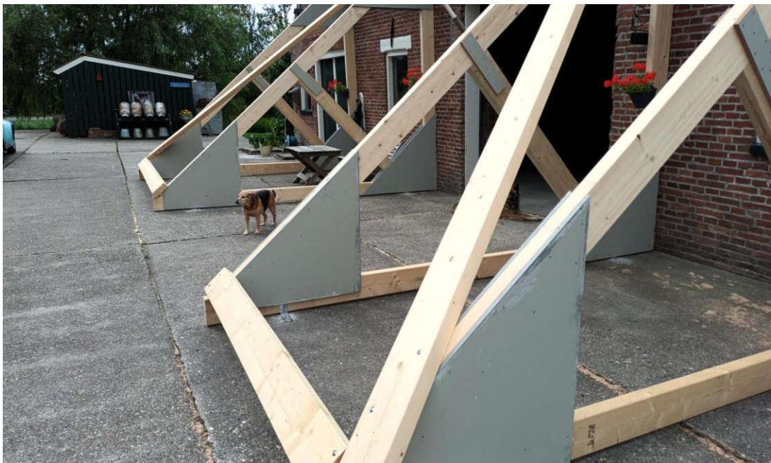
Figuur 1: Voorbeeld stutconstructie
