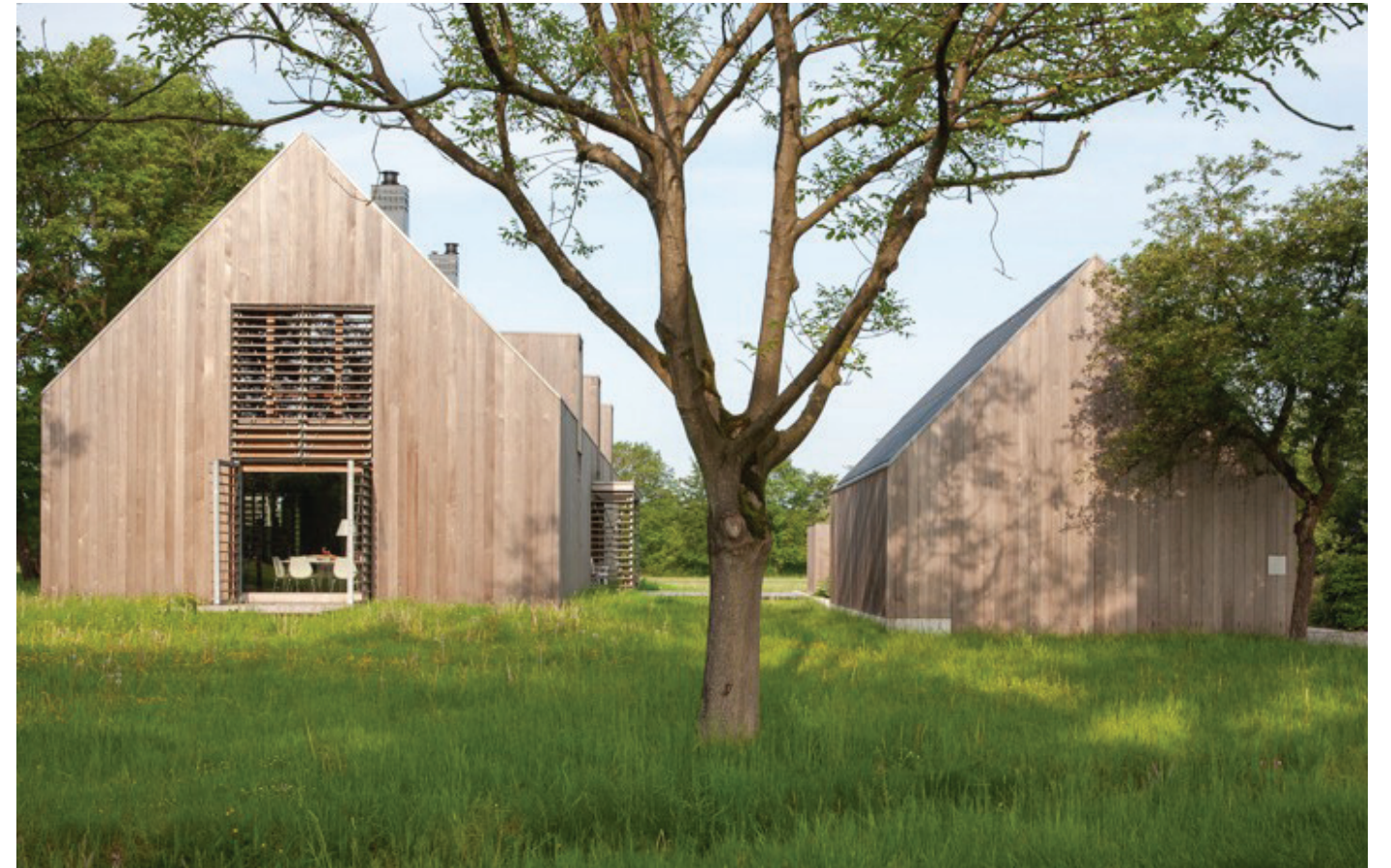
(Schuur)woningen in het landschap: geen duidelijke afbakening van tuin
