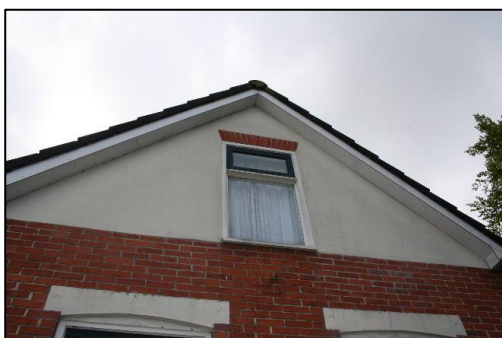
Foto 5. Dakrand van woonhuis
